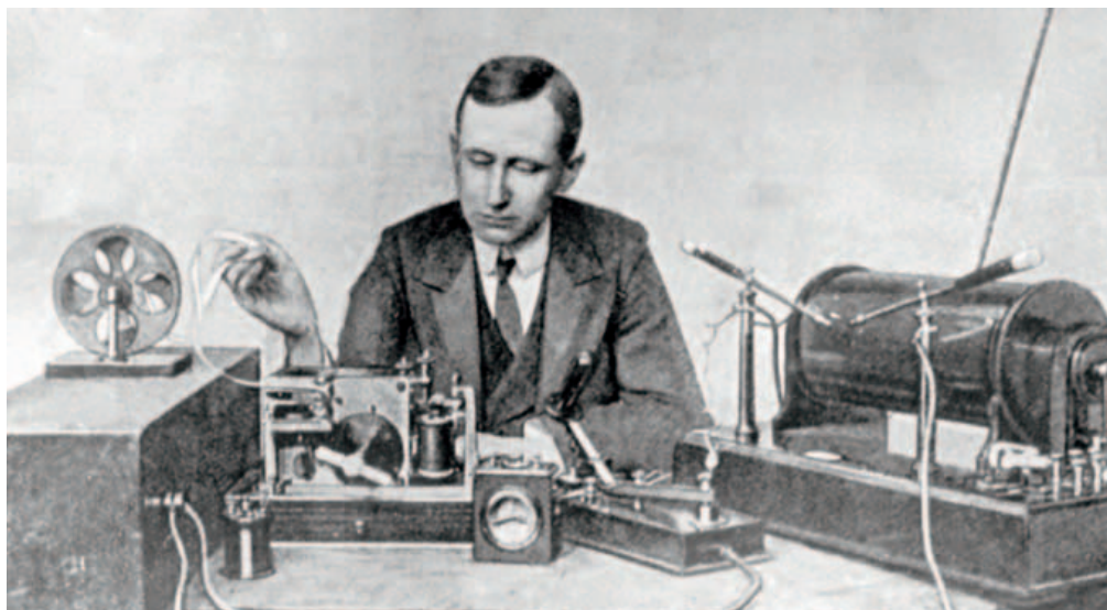
Primi esperimenti radio di Marconi intorno al 1895 con l'impiego di onde hertziane per la trasmissione a distanza
